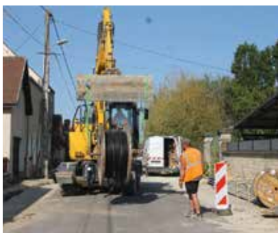
Rue Neuve enfouissement des câbles.
