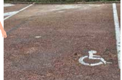
Création d'une place handicapé, place du 8 mai 1945
