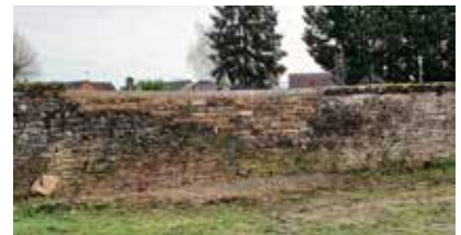
Réfection mur cimetière.
