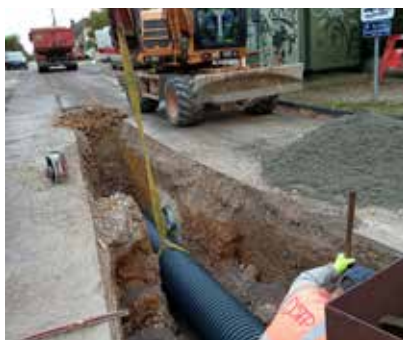
Pose du réseau pluvial rue Neuve.
