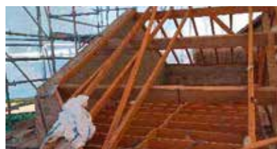
4 La toiture est déposée.
