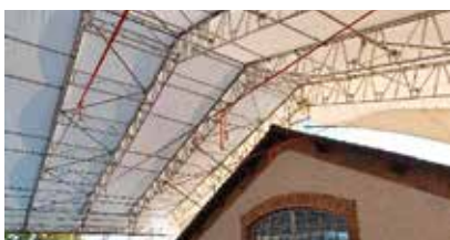
2 Mise en place du parapluie.
